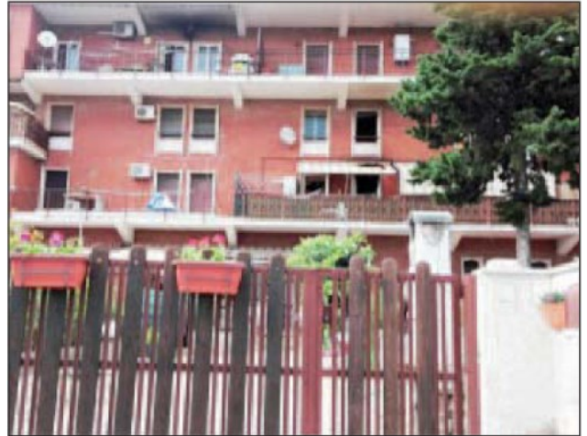
Nella foto un'immagine della palazzina del residence Colle Marina dove sabato sera si è verificato l'incendio
